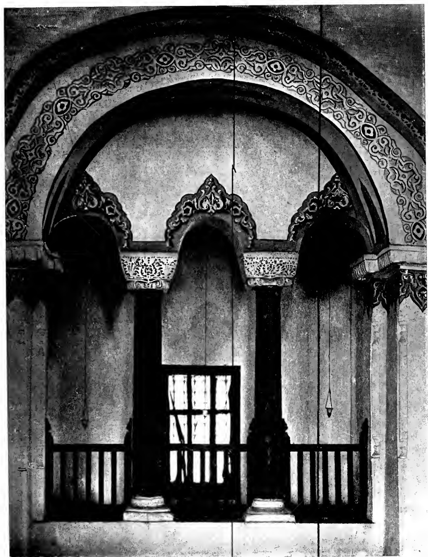
Fig. 100 — Cu'arcata del matroneio dei Santi Sergio e Bacco a Costantinopoli (a. 527-535)
